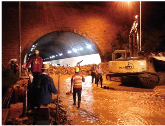
深盐二通道夹门山隧道泥石流应急抢险工作
