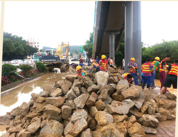
大鹏新区葵涌中学天桥应急抢险工程
