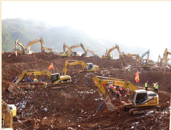
光明新区“12.20”抢险现场
