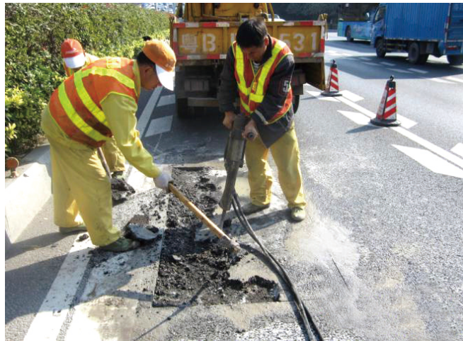
路面坑洞修补采用标准化的圆洞方补
