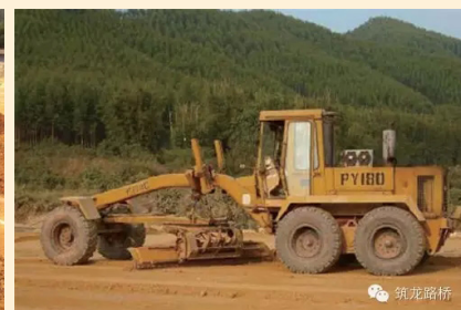
采用平地机精平，有效控制填土表面平整度，并形成路拱。
