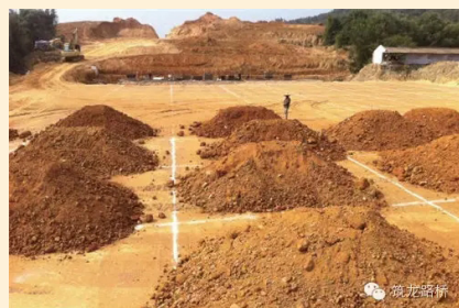
根据装载车辆装土量计算堆土间距，用石灰打方格，人工指挥卸土，从源头控制好分层填土厚度。
