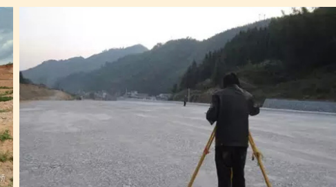
碾压施工时进行实时监测，严格控制沉降差，保证了石方路基填筑质量。
