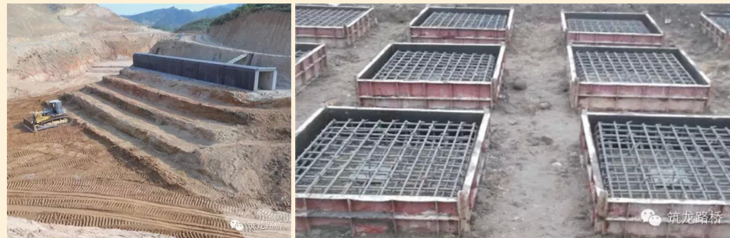
填方路基分段（幅）施工交界处按分层填土厚度开挖台阶。
