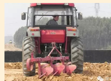
犁铧翻松受浸路基填土。
