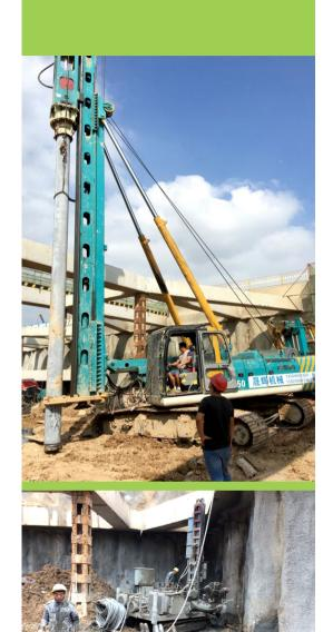
可选择强风化岩层,全风化岩层,坚硬的粘土层或密实的砂层(或卵石层)等多种土质作为持力层,且对持力层起伏变化大的地质条件适应性强,因此适应地域广。
